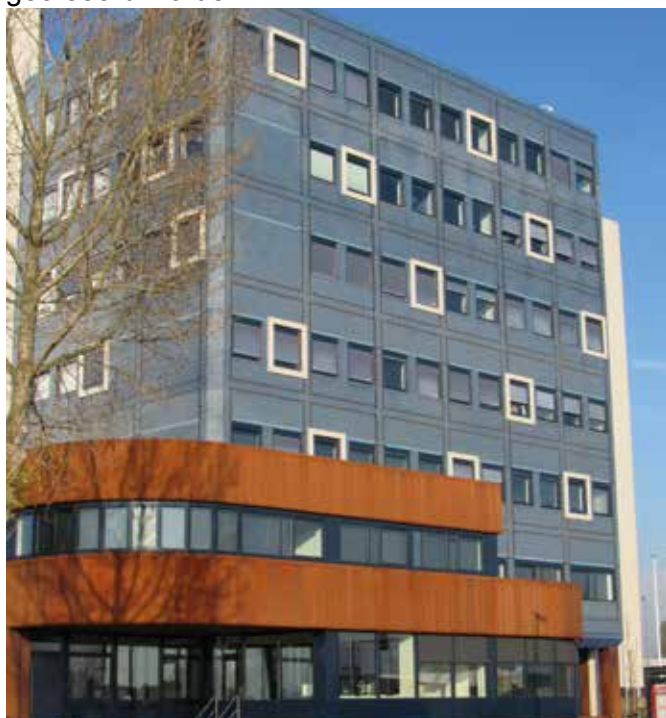
Voormalig politiebureau De Haven, inmiddels gerenoveerd en met nieuwe gebruikers.
