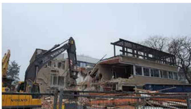
Het gebouw is in 2017 gesloopt en heeft plaats gemaakt voor woningbouw.
