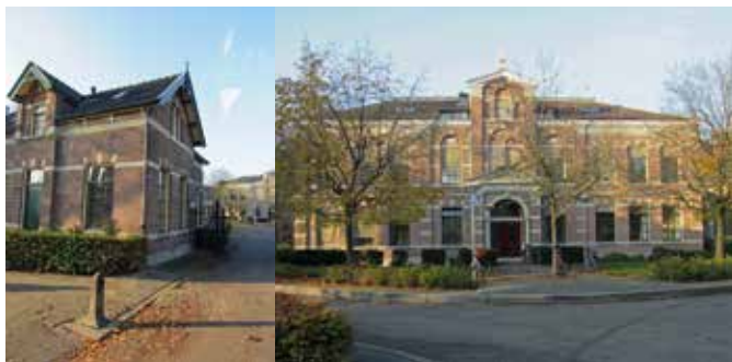
De poortwoning bij de toegang van het voormalig militair terrein en het hoofdgebouw van het militair-complex.
